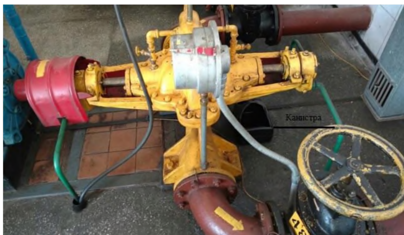
Рисунок 1.15 – Капельная утечка бензина через фланцевое соединение и ее сбор в пластиковую канистру
