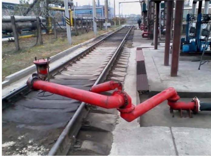
Рисунок 1.9 – Место локальных утечек нефтепродуктов на железнодорожной сливно-наливной эстакаде
